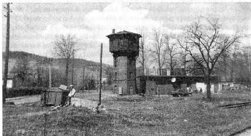
Fot. 4. Wieża ciśnieniowa na stacji w Stroniu Śląskim.
