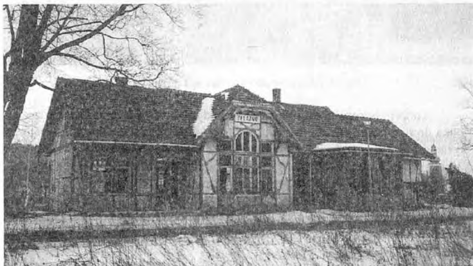
Fot. 1. Budynek stacyjny w Żelaźnie.
